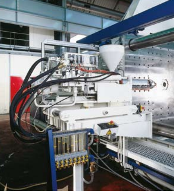
Autarkes Beistellaggregat für die zweite Materialkomponente in L-Stellung auf der Bediengegenseite der Spritzgießmaschine
